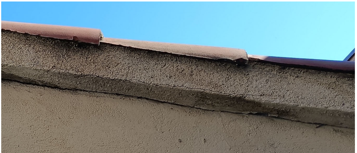
Desprendimiento de enfoscado
