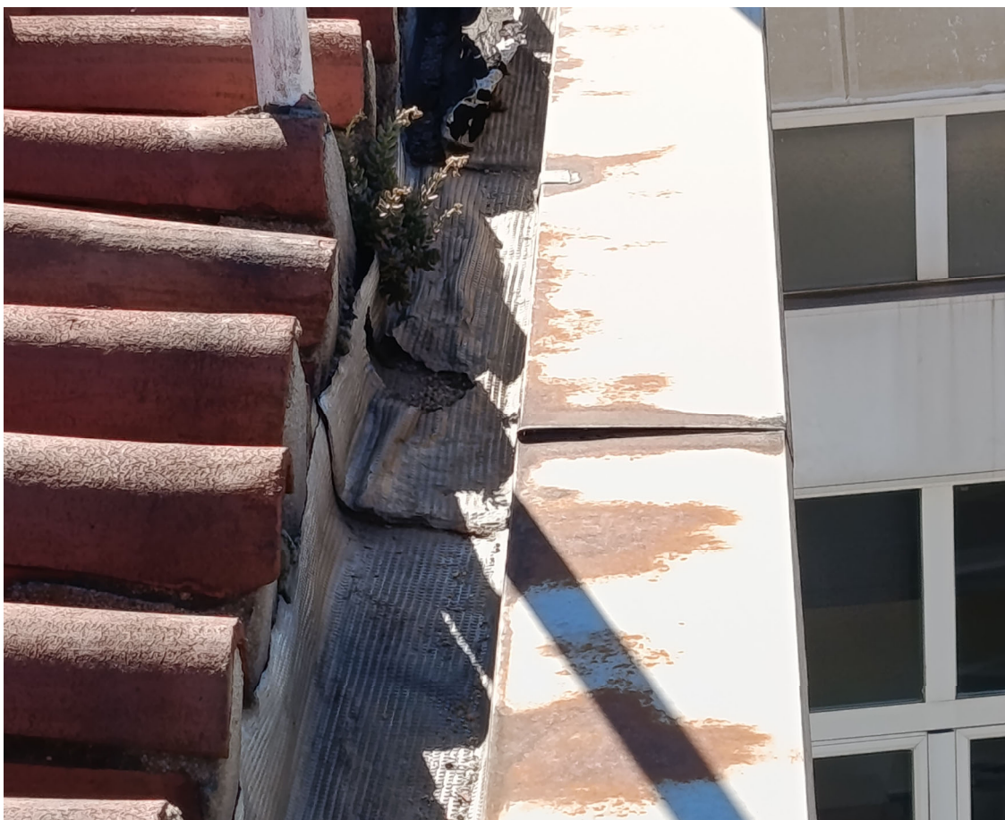
Juntas de babero desplazados, impermeabilización de canalón perdida, crecimiento de vegetación en canalón
