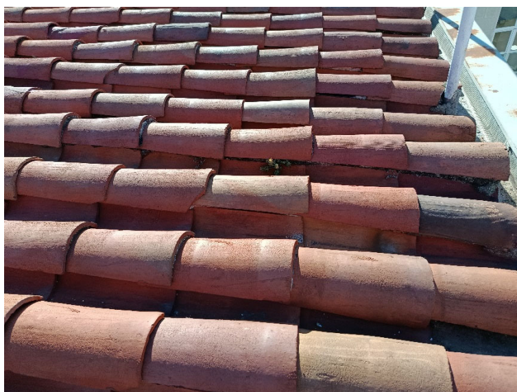
Tejas sin solapar, anclaje de barandilla incorrecto, paño a contrapendiente. Crecimiento de vegetación entre canal y cobija
