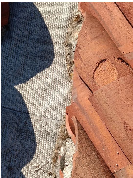
Sumidero de escasa dimensión sin vuelo de canal, remate inadecuado de albardilla de chapa y tela impermeabilizante, altura de canalón 5 cm.
