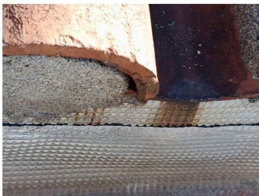
Juntas de babero desplazados, impermeabilización de canalón perdida, crecimiento de vegetación en canalón
