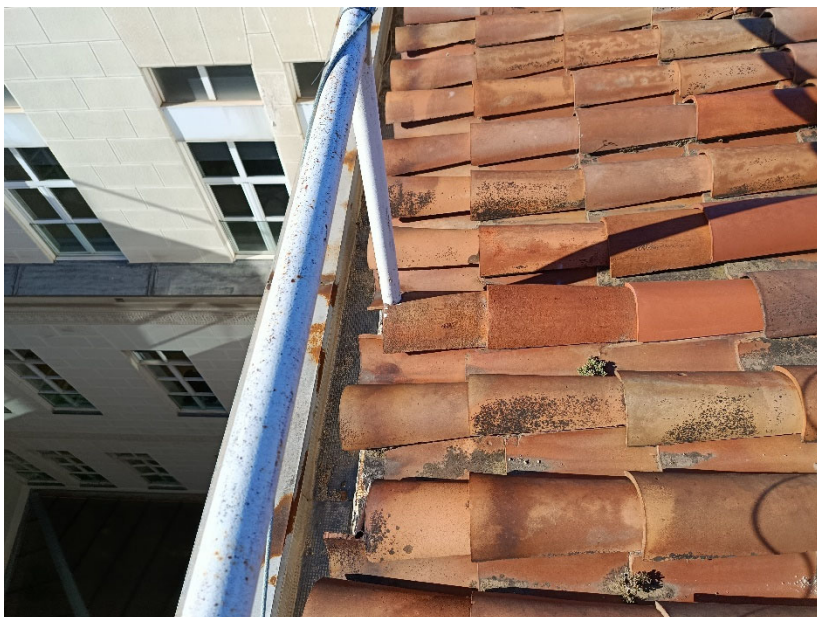
Canalón lleno de depósitos sin pendiente, sin vuelo de tejas, incluso en algunos casos sin llegar al borde del mismo, Babero oxidado y sin solape con el canalón
