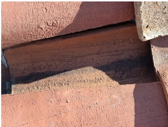
Detalle de las tejas envejecidas, rotas, de distinta geometría, porosas y abiertas
