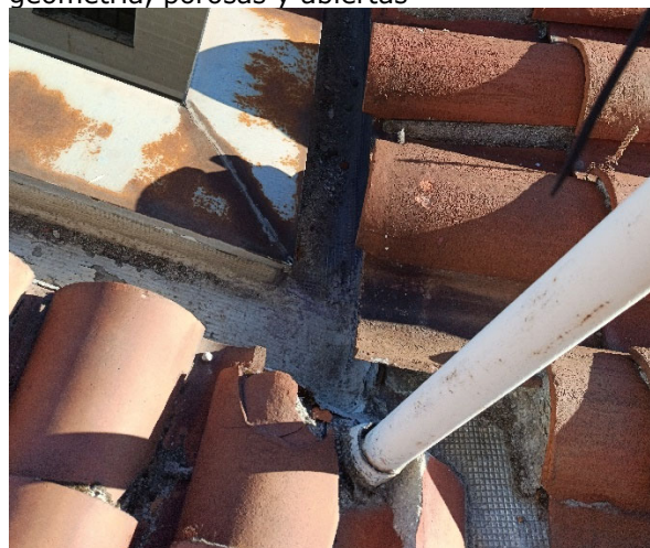
Detalle de las tejas envejecidas, rotas, de distinta geometría, porosas y abiertas
