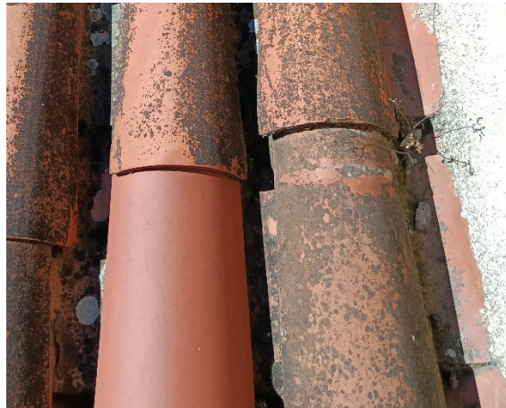
Canales de dimensión inferior a 5 cm, llenos de residuos de mortero, tejas recibidas a muro rotas
