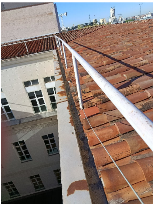
Canalón lleno de depósitos sin pendiente, sin vuelo de tejas, incluso en algunos casos sin llegar al borde del mismo, Babero oxidado y sin solape con el canalón
