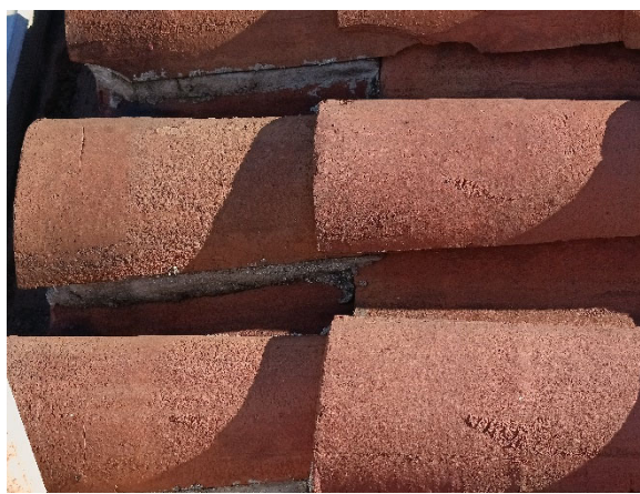
Detalle de las tejas envejecidas, rotas, de distinta geometría, porosas y abiertas
