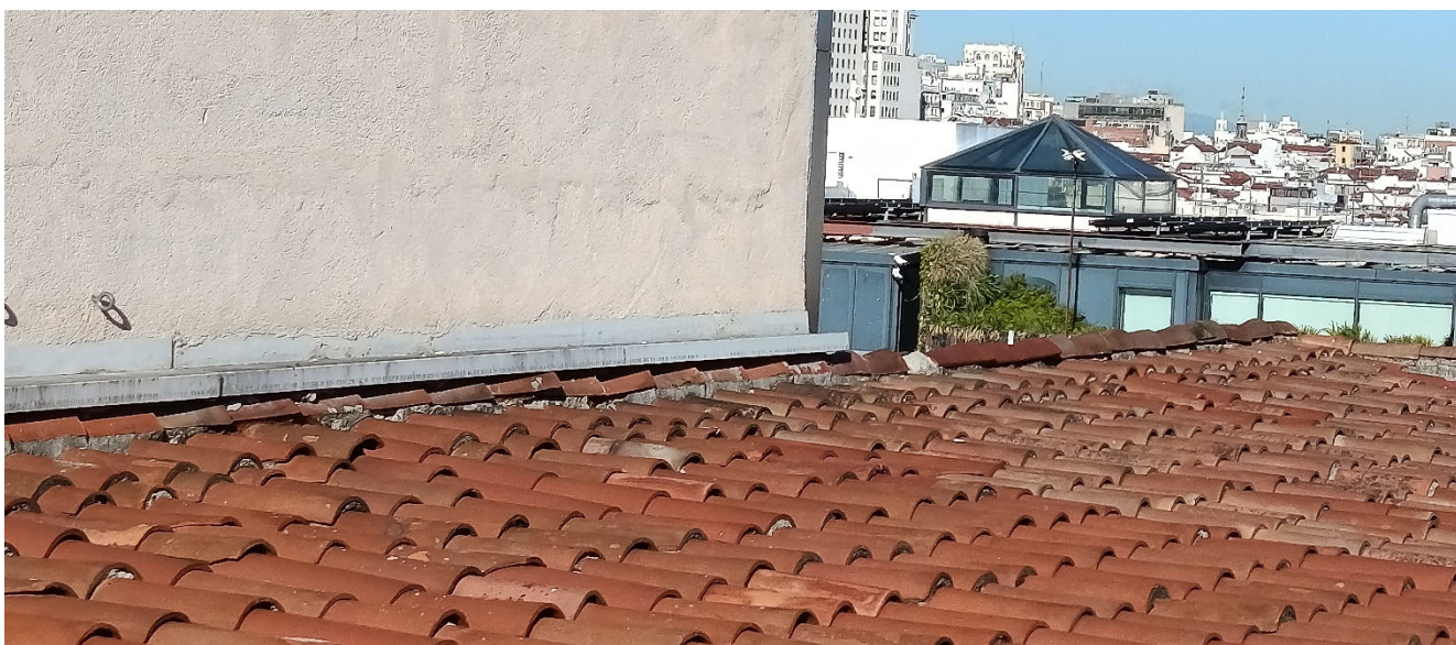
Remate de tejas descolocado y con falla de solape, incluso perdidas en zona colindante con patio en medianera
