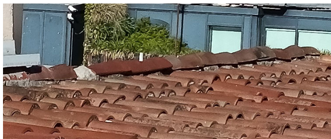
Remate de tejas descolocado y con falla de solape, incluso perdidas en zona colindante con patio en medianera
