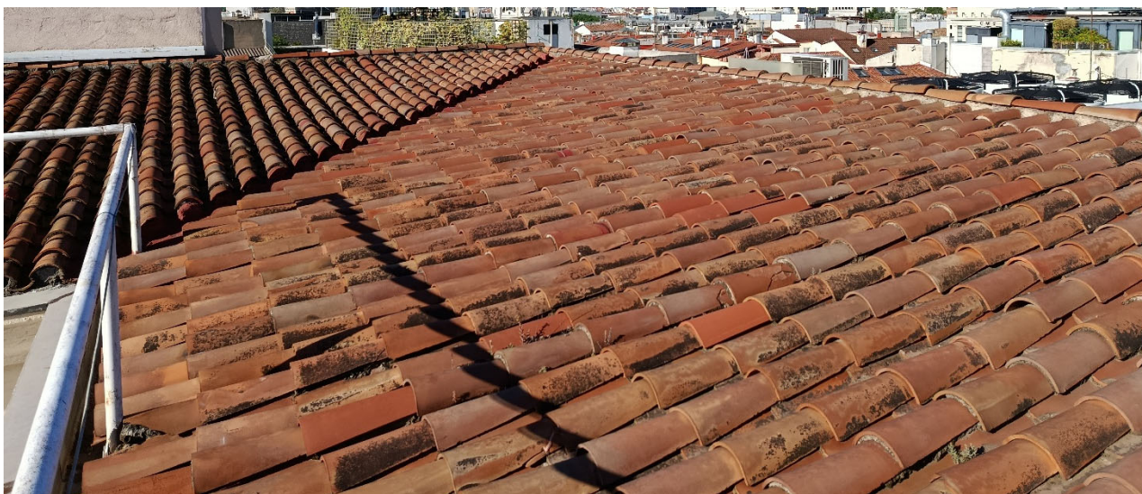
Canalón lleno de depósitos sin pendiente, sin vuelo de tejas, incluso en algunos casos sin llegar al borde del mismo, Babero oxidado y sin solape con el canalón
