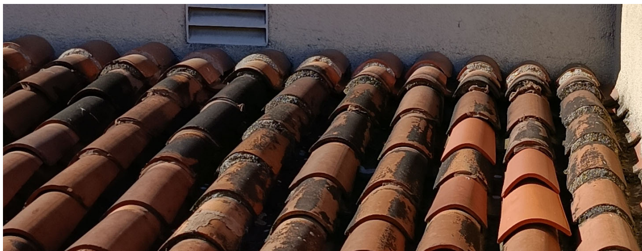
Tejas de distinta curvatura, rellenos de espuma degradados, canales insuficientes, pendiente variable.
