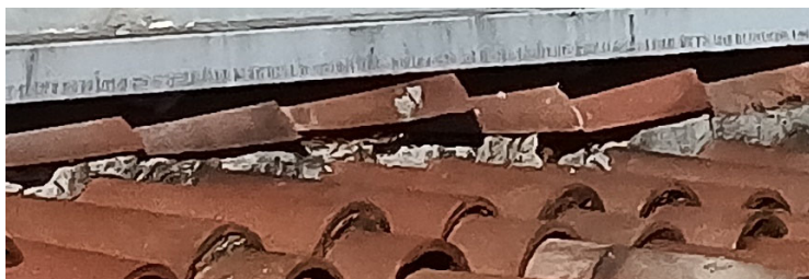
Remate de tejas descolocado y con falla de solape, incluso perdidas en zona colindante con patio en medianera
