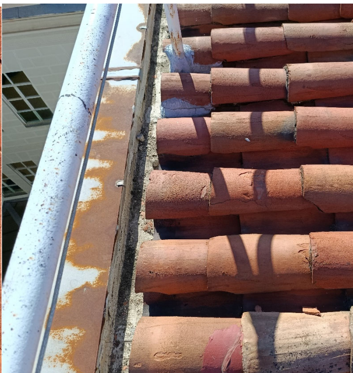
Sumidero de escasa dimensión sin vuelo de canal, remate inadecuado de albardilla de chapa y tela impermeabilizante, altura de canalón 5 cm.
