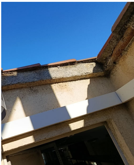
Desprendimiento de enfoscado
